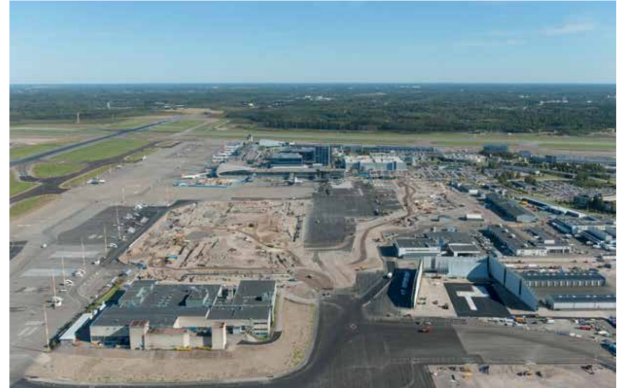
Kuva 25. Uuden koekäyttöpaikan ilmakuva lounaan suunnasta katsottuna. Koekäyttöpaikan kolme seinäkettä sijaitsevat kuvan oikeassa alareunassa.
