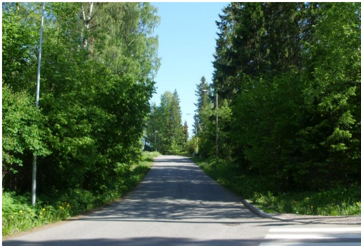
Yhtiöntien osuutta, jolle ei ole rakennettu jalkakäytävää.
