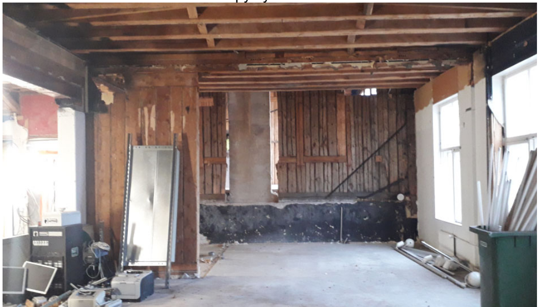
Kuva 2: 1. kerroksen kantavia seinä
