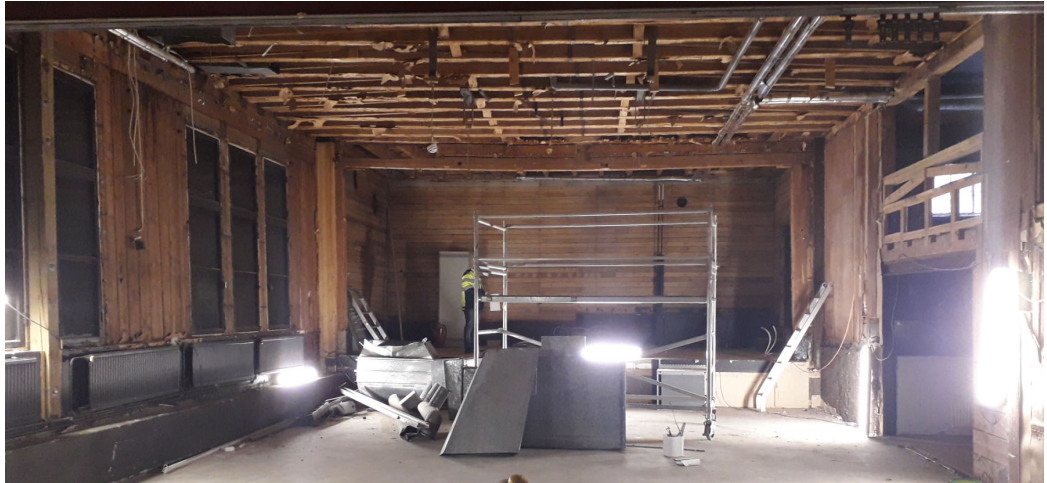
Kuva 4: juhlasali, hirsiseiniä vasemmalla ja puurunkoseiniä telineen takana
