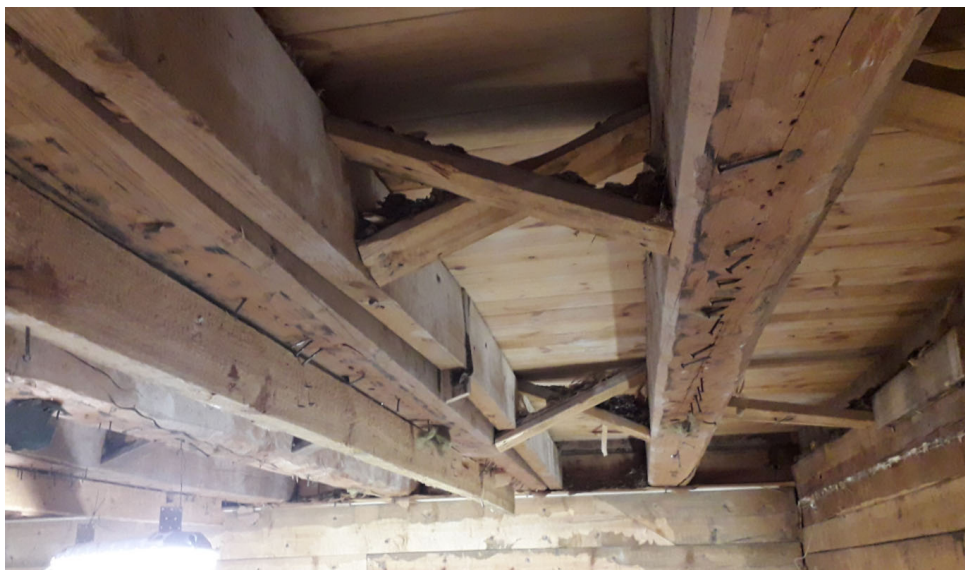
Kuva 3: Välipohjan palkkirakenne ja tukiristikoita
